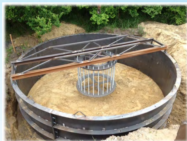
SWP 25-14 betonfundament byggeprocessen. Ringkøbing area, Denmark.
