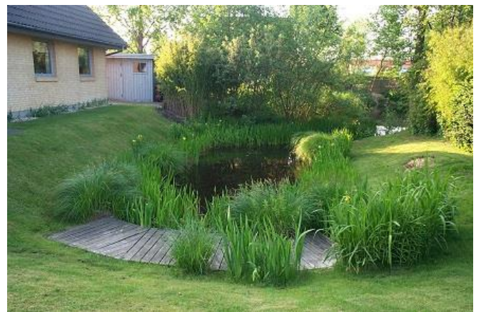
Normal vandstand fotograferet fra Drejøvej 6 mod nordvest, i retning af huset.
